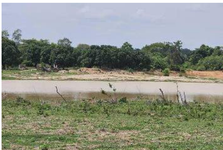
Photo 3: vue du barrage à proximité du site
